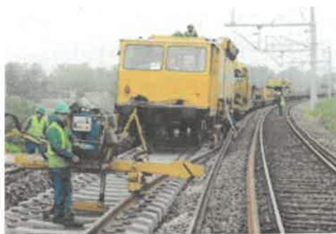
Longs Rails soudés sur traverses béton
